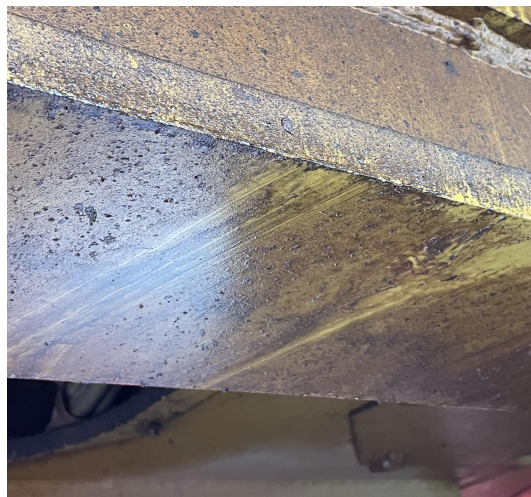
(图10 右侧钢梁刮擦痕)
