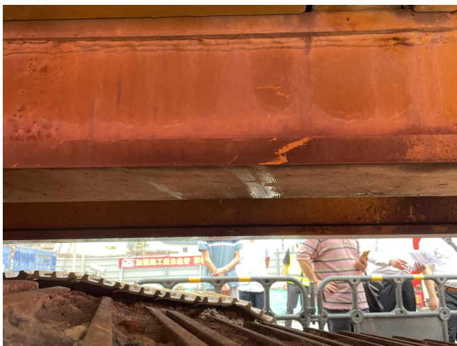
(图9 左侧钢梁刮擦痕)
