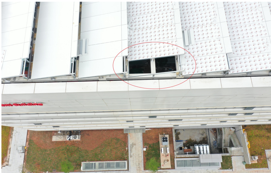
（图 8：9 月 26 日，通过无人机高空航拍钢结构铝板上方）
