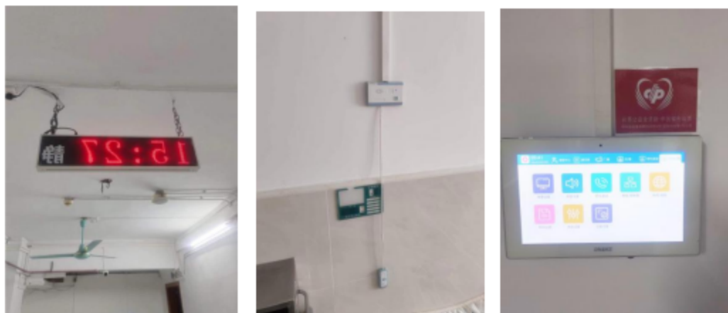
(呼叫系统进行维保照片)
