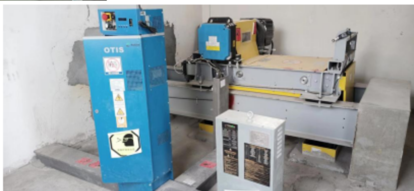
(旧电梯更换前照片)
