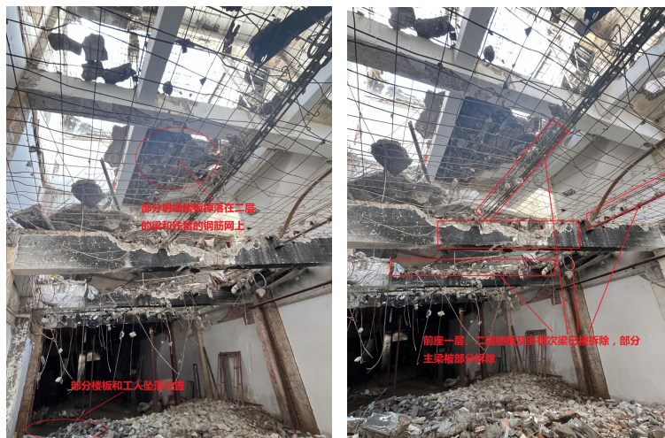
（图 2、图 3 房屋拆除状况）
