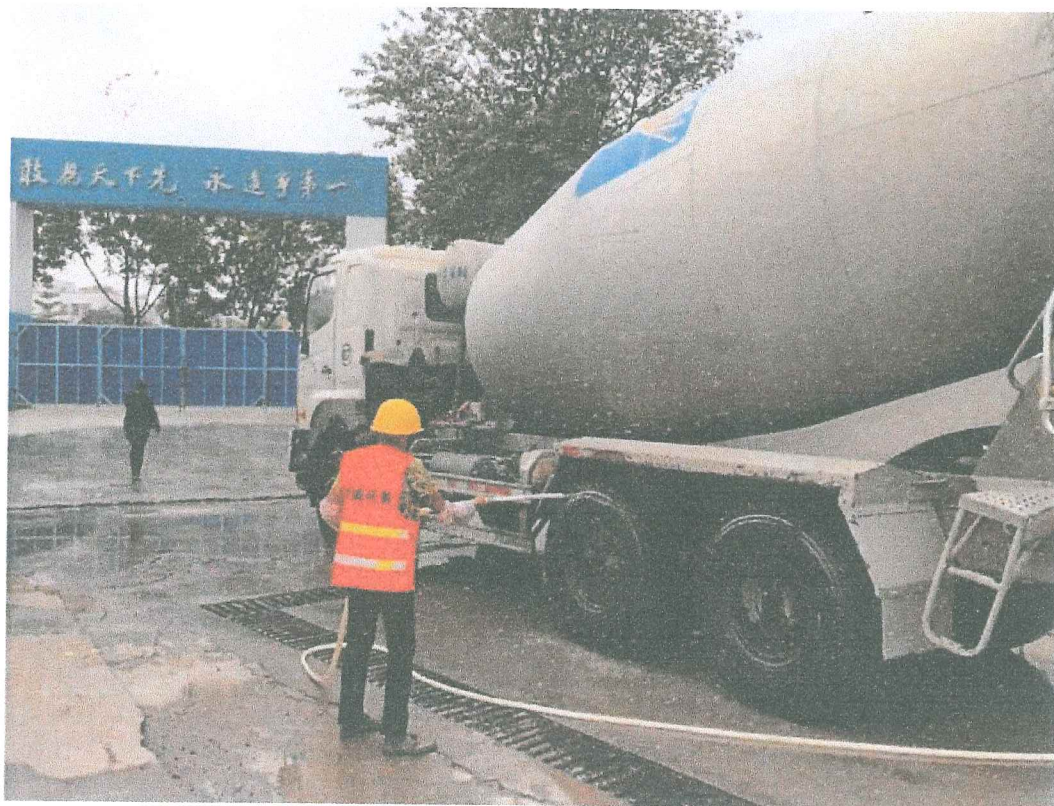
出入工地车辆冲净车轮车身(整改中)
