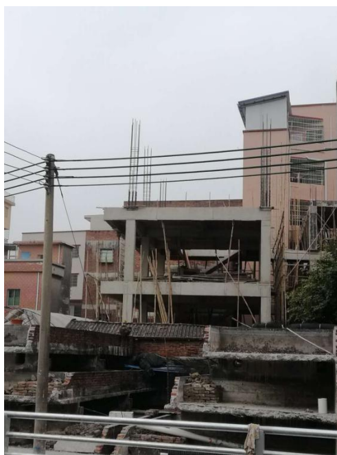
海中南约 17 之一号拆除后情况
