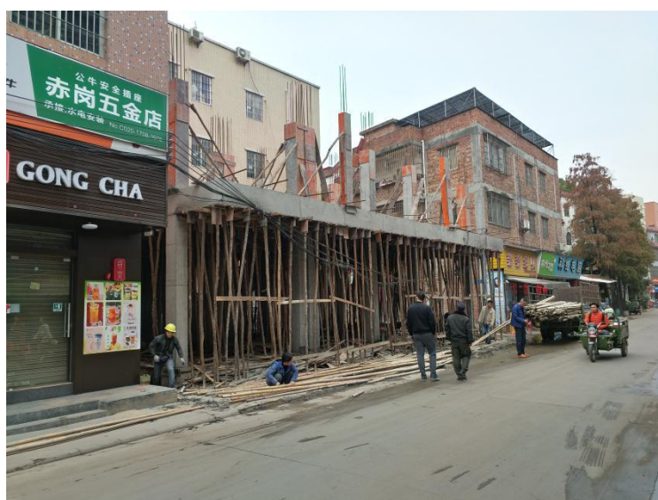
赤岗西约 303 号拆除后情况
