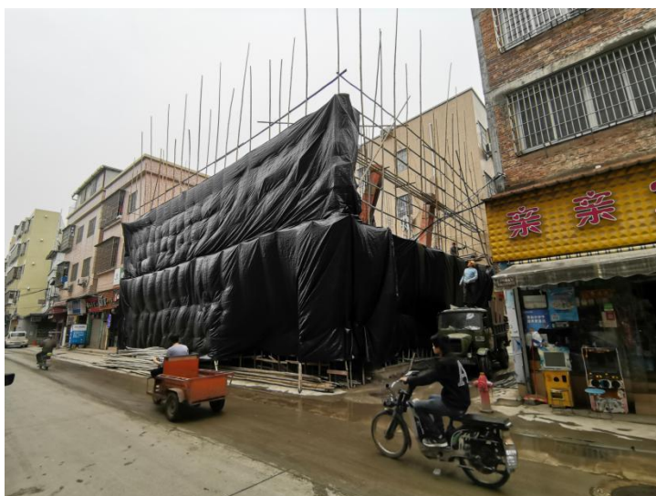
赤岗西约 303 号拆除前情况
