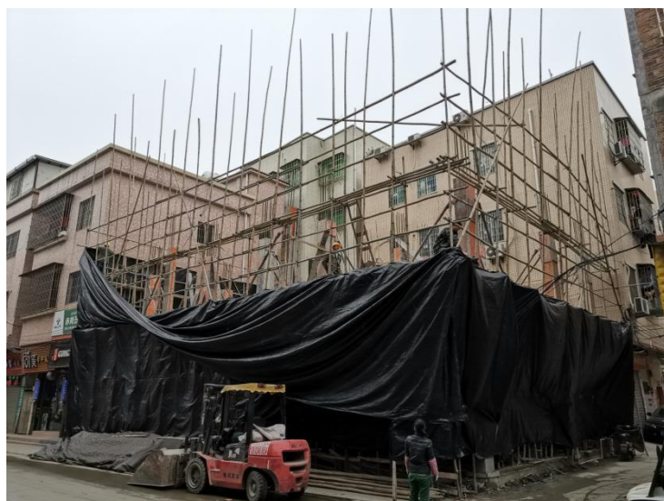
赤岗西约 303 号拆除中情况
