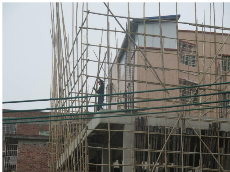
海中南约 17 之一号拆除中情况
