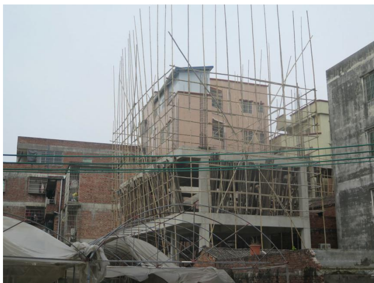
海中南约 17 之一号拆除前情况
